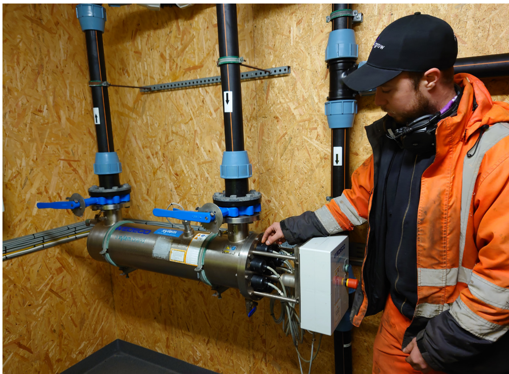
Bild på rör med UV-belysning för vattenrening i teknikhuset på Emmaboda GK.
